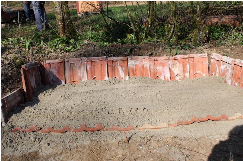
Schritt 7: Zweite Ziegelschicht quer auslegen. Eventuelle Unebenheiten ausgleichen.
