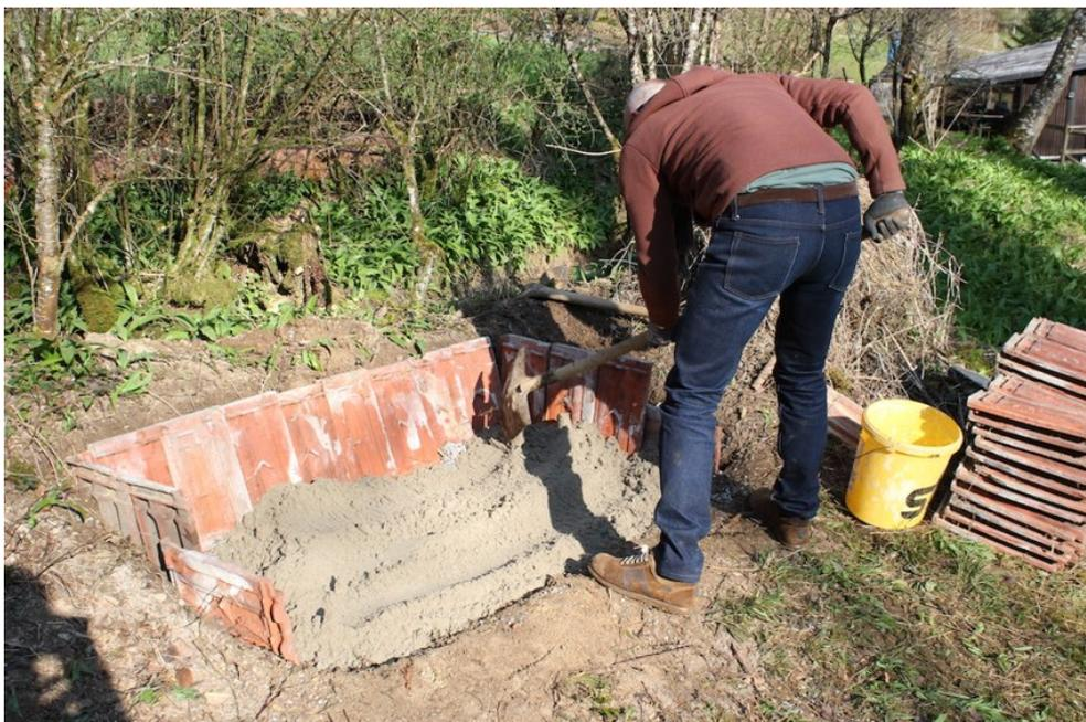
Schritt 5: Erste Ziegelschicht auf dem Sand so auslegen, dass sich die Ziegel wie auf dem Dach seitlich überlappen
