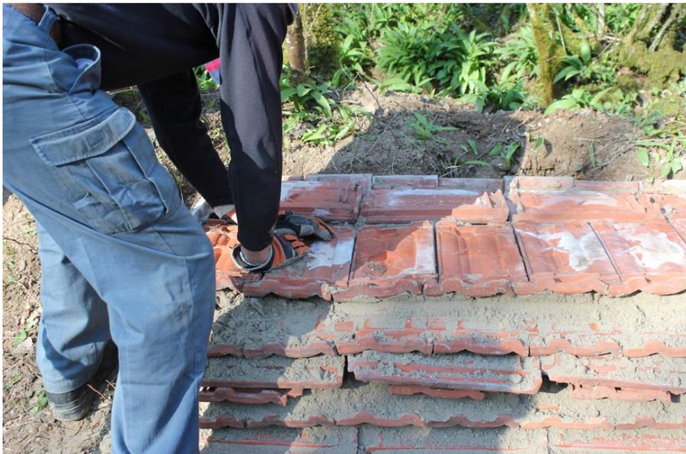
Schritt 12: Als Abschluss können mehrere Schichten Ziegel ohne Sand verlegt werden, dass Zwischenräume entstehen können
